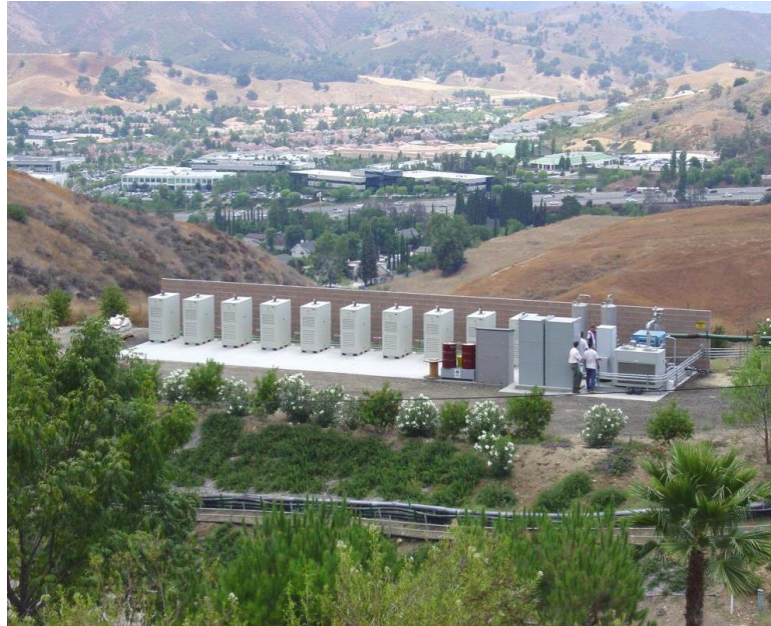
Calabasas Landfill Micro Turbines
