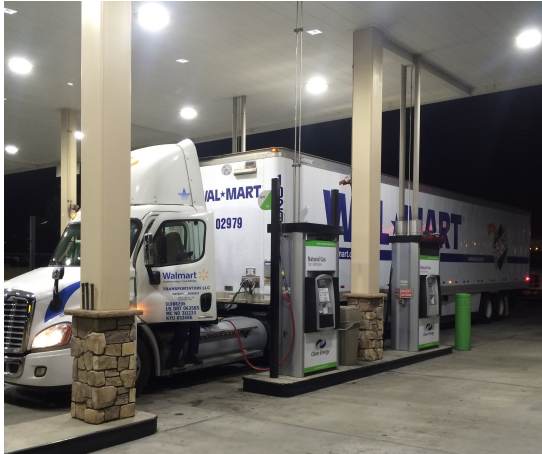
Figure 3: Perris LNG Station
