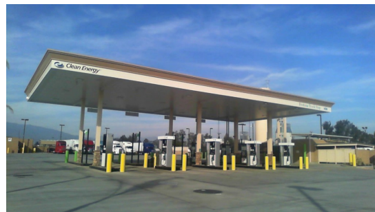
Figure 2: Fontana LNG Station
