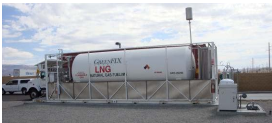
Figure 1: LNG Storage Tank
