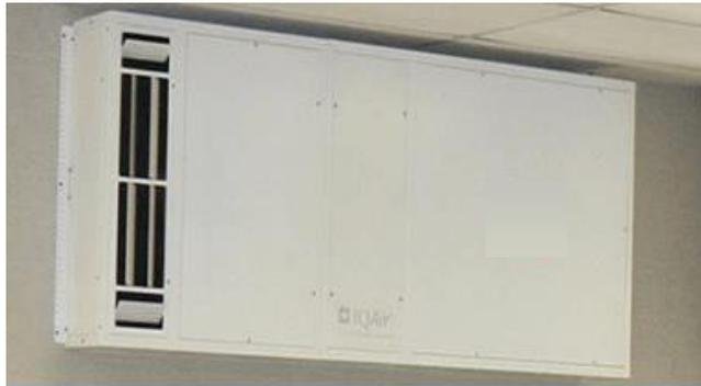
Sistema De Filtración Montado En La Pared
