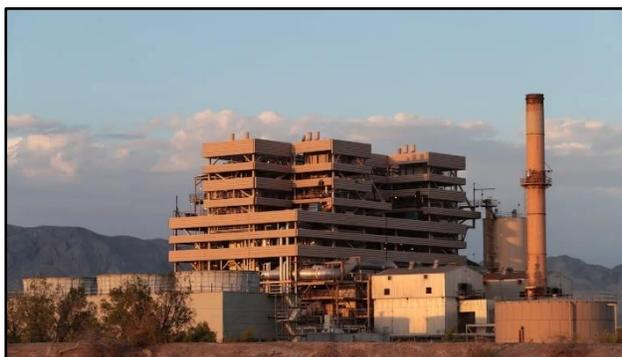
generar electricidad. Esta instalación funciona como una central eléctrica de vapor<sup>1</sup>. Normalmente, estas plantas de energía funcionan quemando combustible en un horno para generar calor que se utiliza en una caldera que produce vapor. El vapor fluye hacia la turbina, la cual que está conectada a un generador para generar electricidad, y hace girar las palas dentro de ella.
