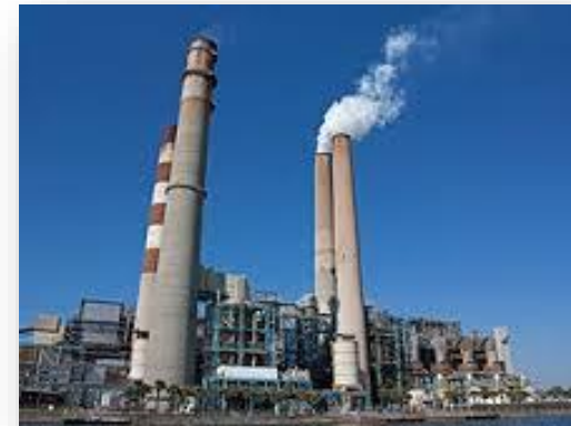
Planta de energía
